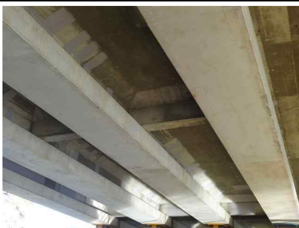
바닥판 및 거더 전경
