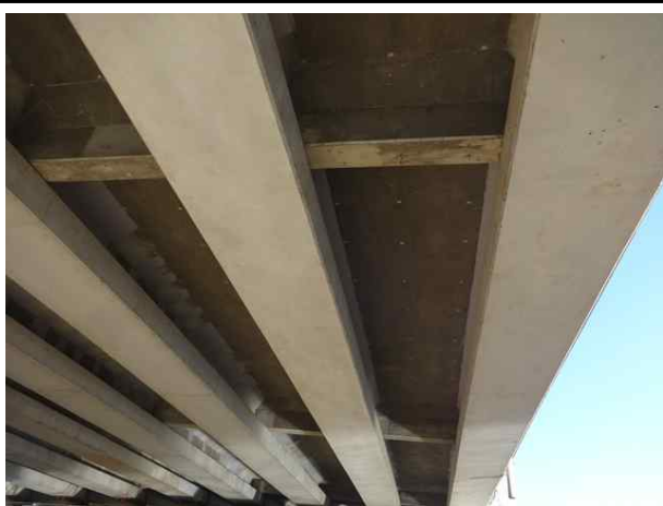
바닥판 및 거더 전경
